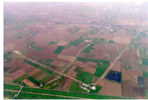
Vue aérienne du site en cours de construction près de Cascina (Italie)
