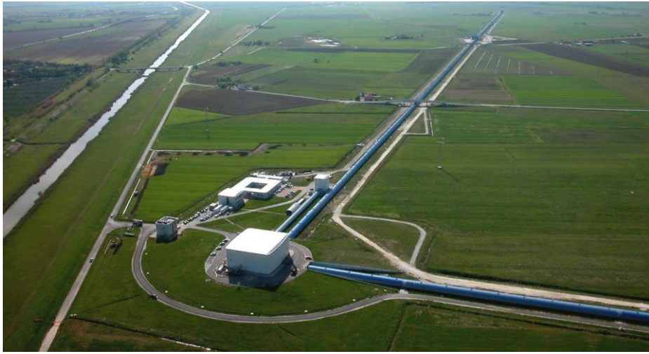
Vista aerea dell'interferometro Virgo: in questa foto si può apprezzare chiaramente la forma ad L dell'interferometro di Michelson
